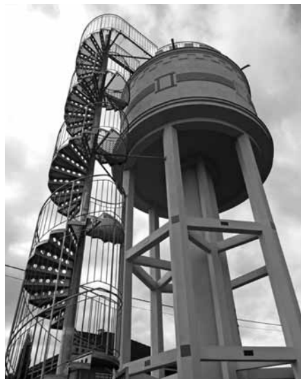
PO SCHODIŠTI VZHŮRU NA VYHLÍDKU
