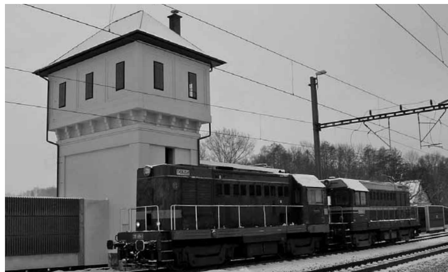
ŽELEZNIČNÍ KORIDOR A ZACHRÁNĚNÝ DRÁŽNÍ VODOJEM V ČERČANECH
