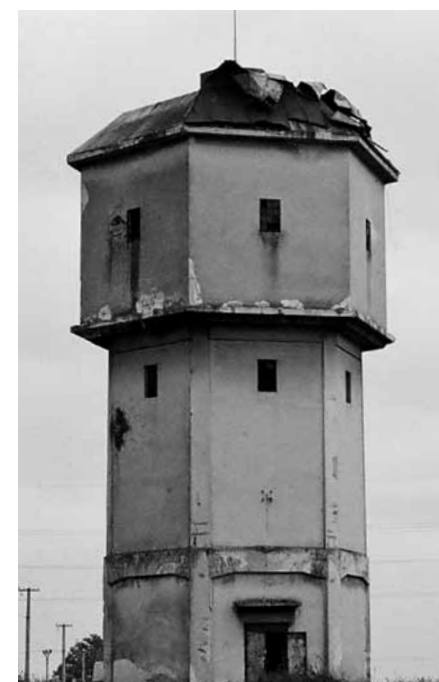
VÝCHOZÍ STAV PŘED REKONSTRUKCÍ
