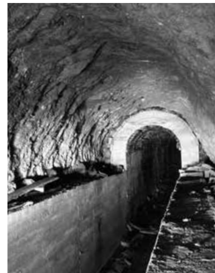
PODZEMNÍ ČÁSTI TVRZE BYLO NUTNO VYČISTIT A ZABEZPEČIT.
