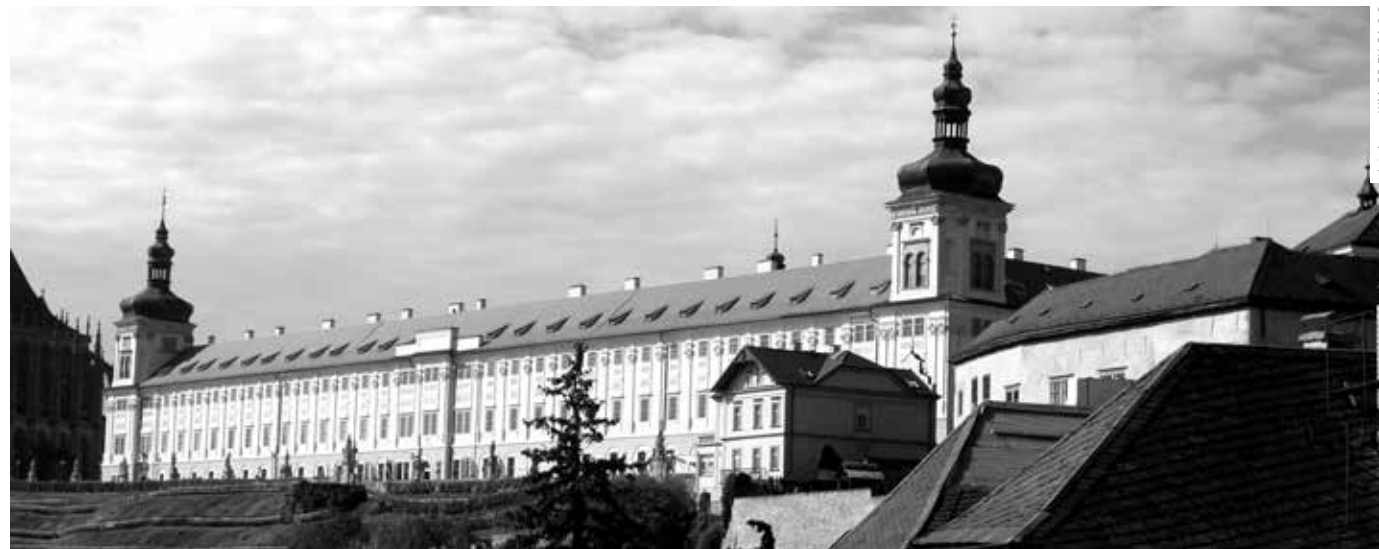
V PRAŽSKÉ ORGANIZACI VOZÍČKÁŘŮ OCEŇUJÍ PŘÍSTUPNOST HISTORICKÉHO CENTRA KUTNÉ HORY VČETNĚ BÝVALÉ JEZUITSKÉ KOLEJE.
