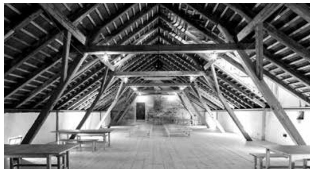
PODKROVÍ BYLO CITLIVĚ OPRAVENO, VYUŽÍVÁ SE KE KULTURNÍM AKCÍM.
