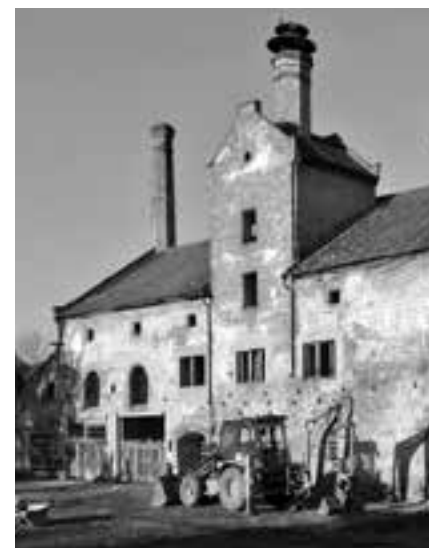
ZCHÁTRALÝ PIVOVAR PŘED REKONSTRUKCÍ
