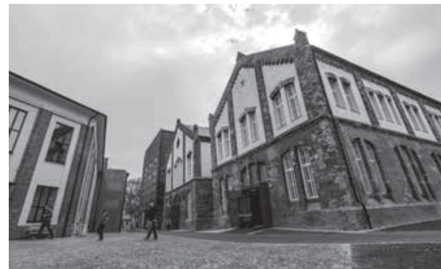
OSTRAVSKÝ DŮL HLUBINA ZÍSKAL V ROCE 2015 OCENĚNÍ STAVBA ROKU.
