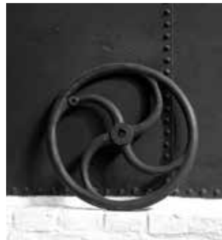
PODAŘILO SE ZACHRÁNIT MNOHO PŮVODNÍCH PRVKŮ.
