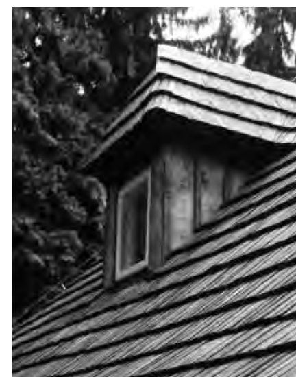
OBNOVENÝ VIKÝŘ S DETAILEM STŘECHY ZE SMRKOVÉHO ŠTÍPANÉHO ŠINDELE
