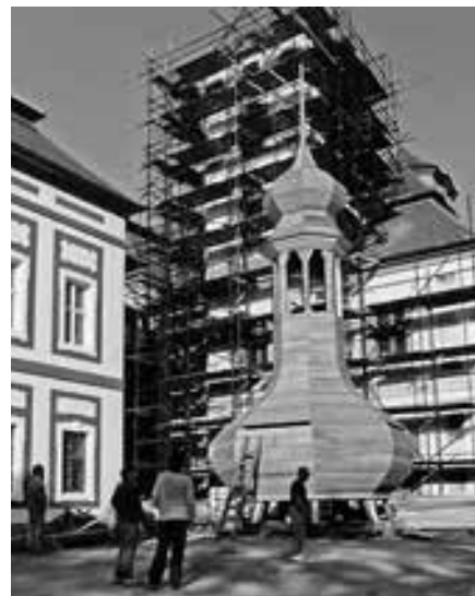
OPRAVA VÝCHODNÍ ZVONICE V OBJEKTU PROBOŠTSTVÍ V ROCE 1993
