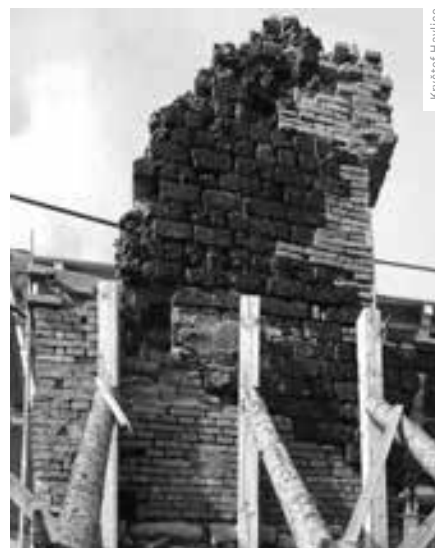
STRUSKOVÉ CIHLY BYLY HOJNĚ POUŽITY BĚHEM PŘESTAVBY V 19. STOLETÍ.
