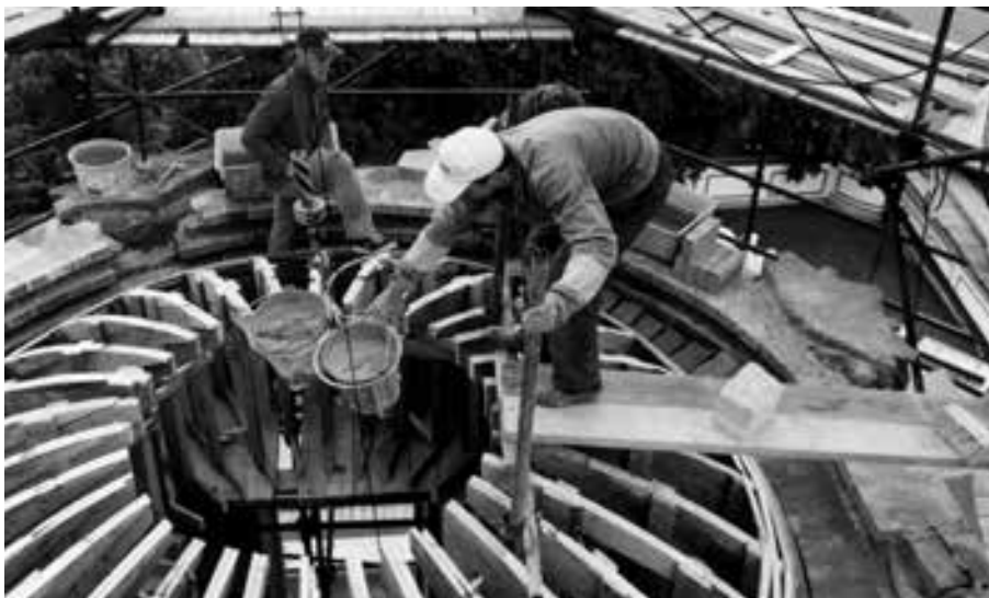
PRÁCE NA REKONSTRUKCI LUCERNY KOSTELA ZVĚSTOVÁNÍ PANNĚ MARIÍ V ROCE 2000
