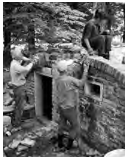
V ROCE 2014 PRACOVALI DOBROVOLNÍCI V ČERVENÉM DVOŘE NA REKONSTRUKCI MAURICOVNY.
