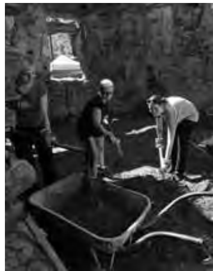
VYKLÍZENÍ SUTIN Z DOSUD NEOPRAVENÉ ČÁSTI ZŘÍCENINY HRADU HARTENBERG
