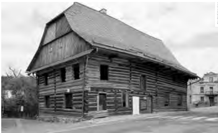
POHLED NA DŘEVĚNKU V ÚPICI PŘED OSAZENÍM OKEN V ROCE 2017
