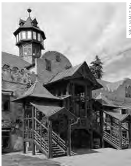
KONSTRUKCE VENKOVNÍHO SCHODIŠTĚ BYLA REPASOVÁNA.
