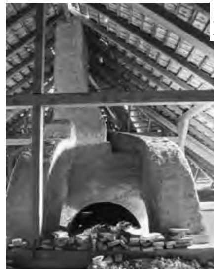
POHLED DO KROVOVÉ KONSTRUKCE PŘED ZAHÁJENÍM OBNOVY
