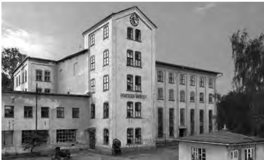
SOUČASNÝ VZHLED NOVÉ TKALCOVNY VYBUDOVANÉ V ROCE 1899
