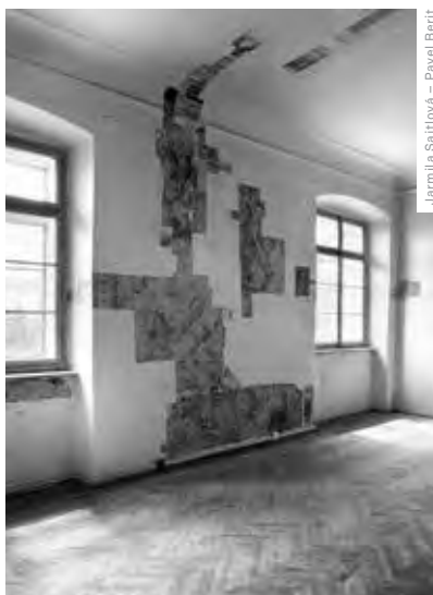
ODKRYVÁNÍ STARŠÍCH OMÍTKOVÝCH VRSTEV V DOLNÍM ZÁMKU
