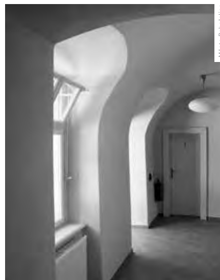
DETAIL OBNOVENÉHO INTERIÉRU
