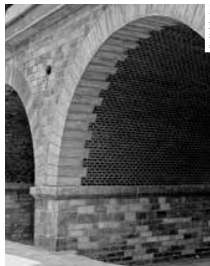
ČÁST OBNOVENÉ KLENBY
