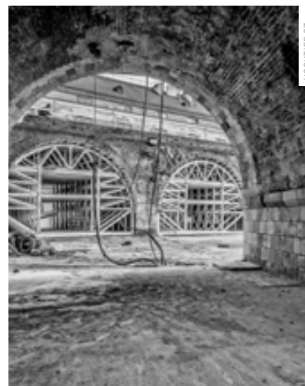
DETAIL PRŮBĚHU REKONSTRUKCE KLENEB
