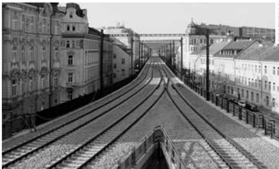
V RÁMCI ÚPRAVY ŽELEZNIČNÍHO SVRŠKU JSOU SJEDNOCENY TRAKČNÍ STOŽÁRY A NÁVĚSTNÍ LÁVKY.
