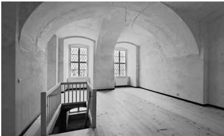
OBNOVENÝ ZAKLENUTÝ PROSTOR S DŘEVĚNÝM SCHODIŠTĚM
