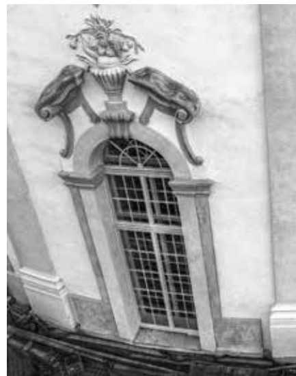
DETAIL OBNOVENÉHO OKNA S NADOKENNÍ ŘÍMSOU
