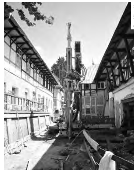
POD HISTORICKÝMI OBJEKTY VZNIKLY SUTERÉNNÍ PROSTORY.
