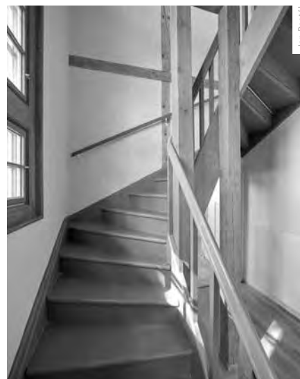
OBNOVENÉ JURKOVIČOVO SCHODIŠTĚ
