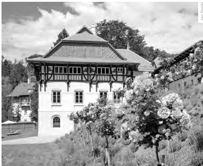
DETAIL HRÁZDĚNÉ NÁSTAVBY PO REKONSTRUKCI
