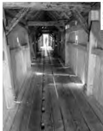
RECHLE V LENOŘE, PRŮHLÉD KRYTOU LÁVKOU
