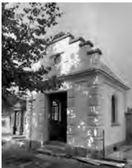
HROBKA V OLDŘICHOVĚ PO OBNOVĚ
