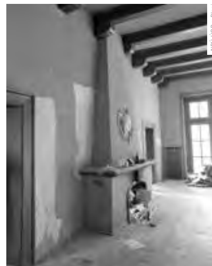
PRŮBĚH REKONSTRUKCE INTERIÉRU
