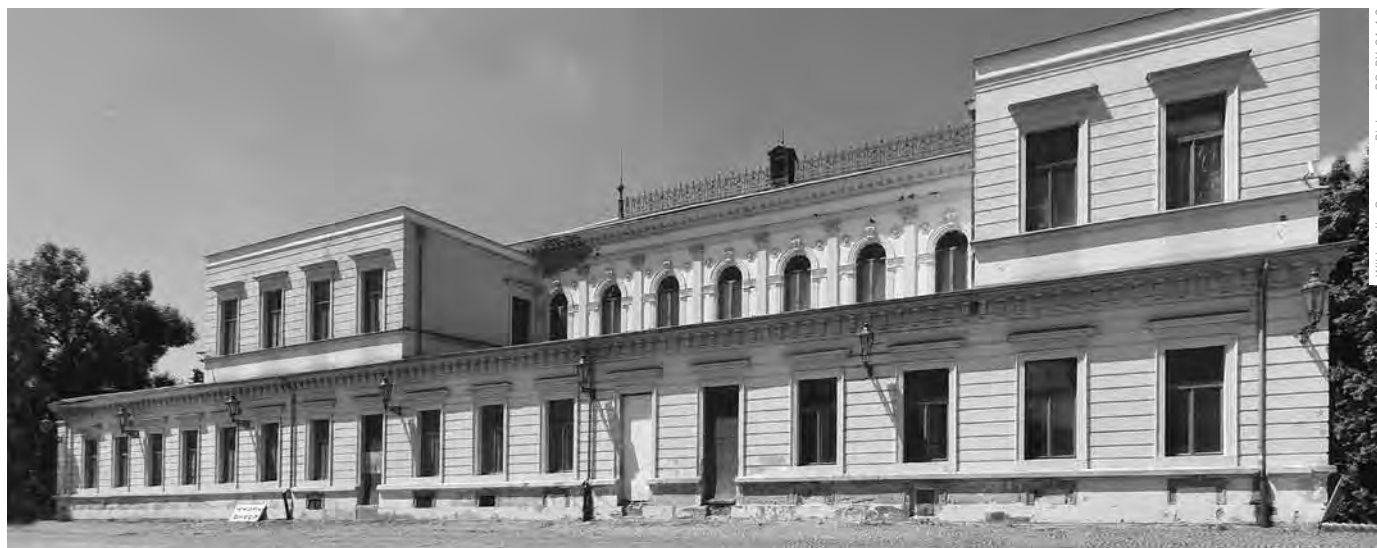
CELKOVÝ POHLED NA BUDOVU PŘED REKONSTRUKCÍ
