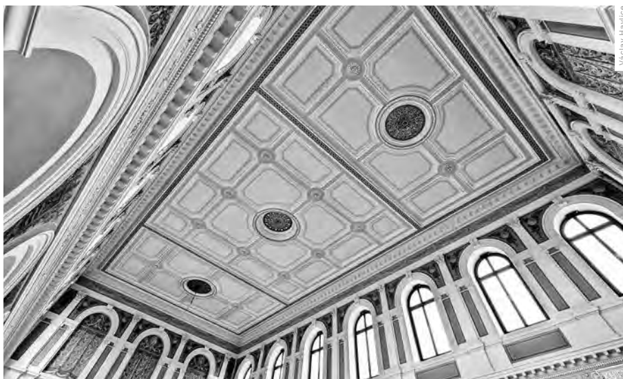
OBNOVENÝ STROP HLAVNÍHO SÁLU PŘED OSAZENÍM LUSTRŮ
