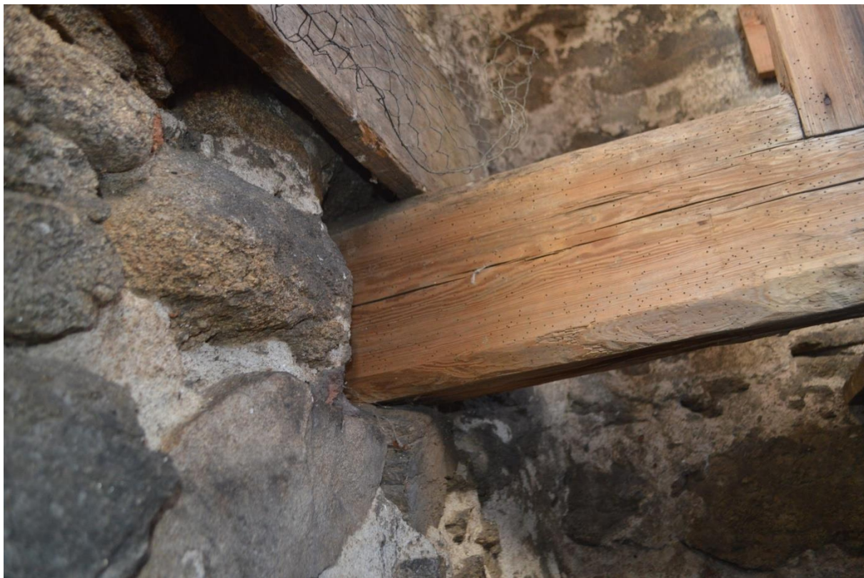
05. Pohled na zazděný trám zvonové stolice
