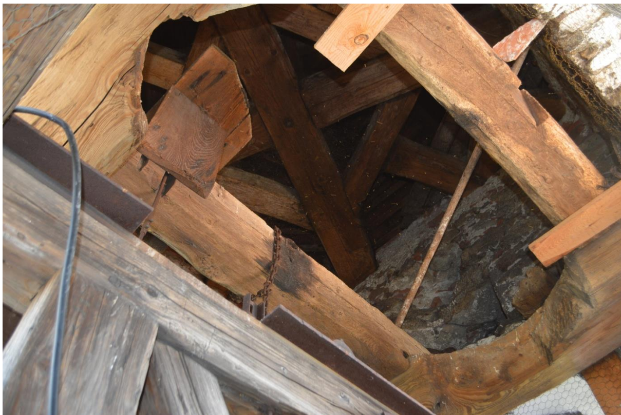
04. Pohled na původní nosné trámy (východní pole) nad okny věže s prodlabáním pro delší výkyv zvonu
