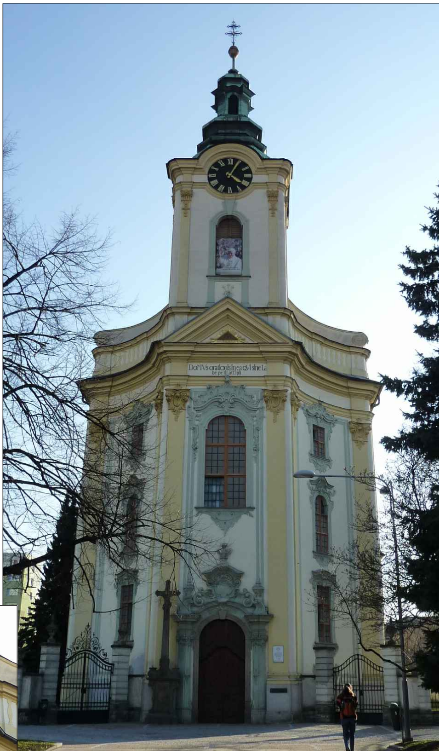
Současný stav po 18 letech od rekonstrukce
