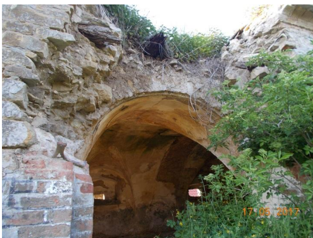
Obr. č. 8 – poslední zbylé klenby chléva II.
