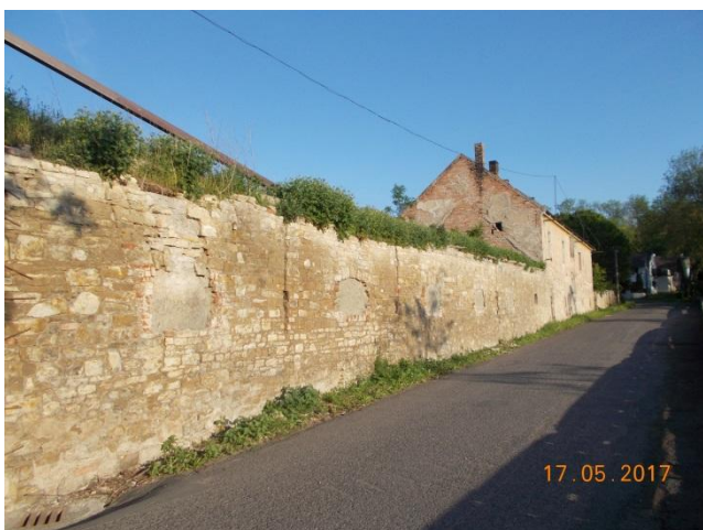
Obr. č. 5 – zadní linie stěny chléva I. navazující na oplocení areálu, Vlevo nahoře výztuha barokního štítu
