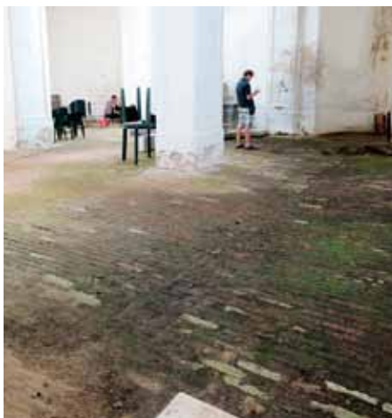
Obr. 13, 14 a 15: Odvod vody kanálkem v jílové vrstvě pod podlahou, patrná vlhká podlaha v místě trasy kanálku
