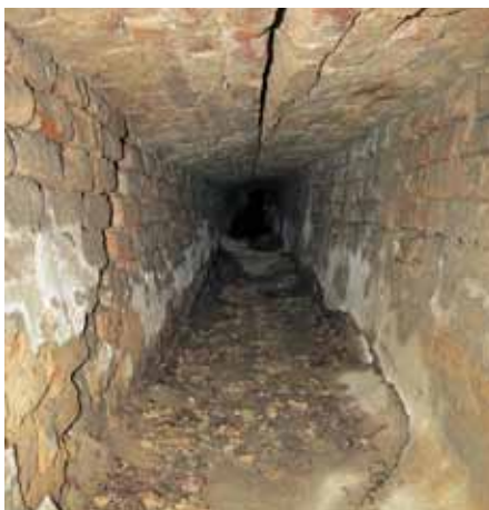
Obr. 10: Pokleslé dno kanálu a rozevření klenby – havárie
