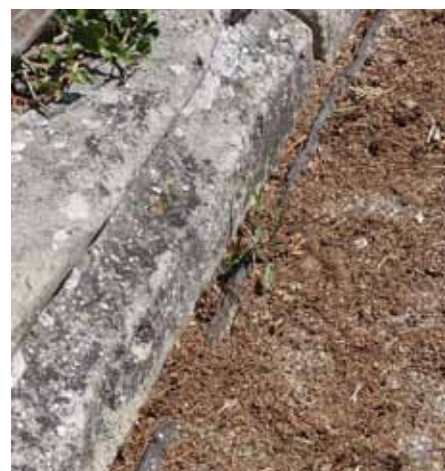
Obr. 4 a 5: Spáry, kterými se může dostávat voda do stropních konstrukcí i zdiva, vznikly při okrajích asfaltového povrchu terasy a mezi okolními konstrukcemi (zábradlí, schodiště, ozdobné prvky atd.)
