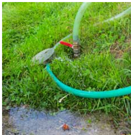
Obr. 17 a 18: Ze zahradního rozvodu vody dochází k výrazným únikům podél kanalizačního kanálu
