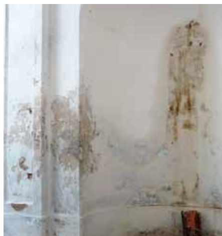
Obr. 6 a 7: Zaústění dešťové vpusti terasy do odvodňovacího kanálu, lokální koncentrace srážkové vody s projevy průsaku v interiéru
