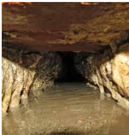
Obr. 13, 14 a 15: Odvod vody kanálkem v jílové vrstvě pod podlahou, patrná vlhká podlaha v místě trasy kanálku
