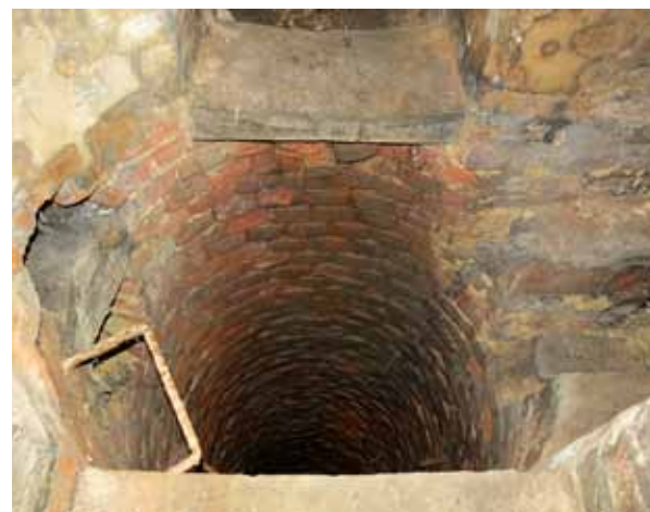
Obr. 8: Kruhová šachta (studna) propojující sběr vody odvodňovacích kanálů (štol) při jižní a východní straně terasy do cihelných kanálů pod podlahou katakomb
