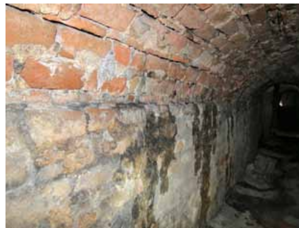
Obr. 17 a 18: Ze zahradního rozvodu vody dochází k výrazným únikům podél kanalizačního kanálu
