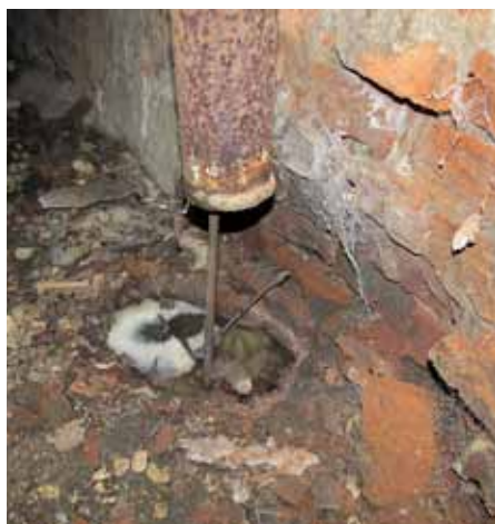
Obr. 6 a 7: Zaústění dešťové vpusti terasy do odvodňovacího kanálu, lokální koncentrace srážkové vody s projevy průsaku v interiéru
