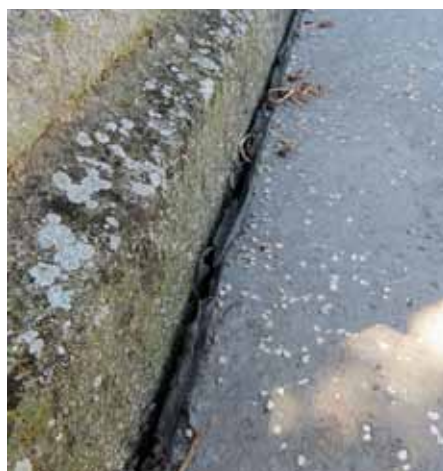
Obr. 4 a 5: Spáry, kterými se může dostávat voda do stropních konstrukcí i zdiva, vznikly při okrajích asfaltového povrchu terasy a mezi okolními konstrukcemi (zábradlí, schodiště, ozdobné prvky atd.)
