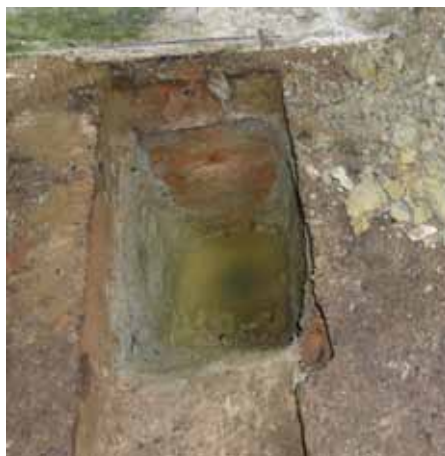
Obr. 16: Kopaná sonda podlahy – ustálená hladina vody v hloubce cca 0,5 m
