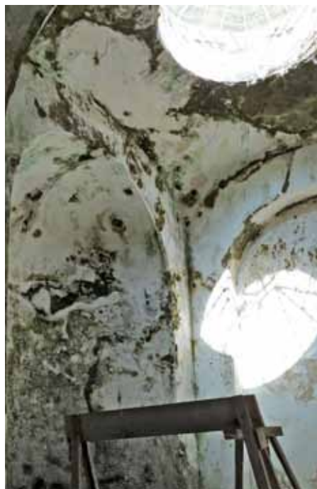
Obr. 24, 25 a 26: Rozsáhlé pokrytí vnitřních konstrukcí mikroskopickými houbami, mechy, lišejníky
