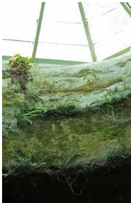
Obr. 24, 25 a 26: Rozsáhlé pokrytí vnitřních konstrukcí mikroskopickými houbami, mechy, lišejníky
