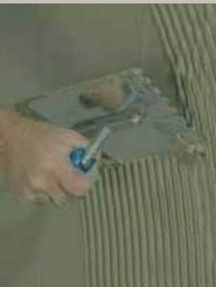
nanášení lepidla KP hřebenem
