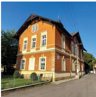
Základní a mateřská škola Želízy
