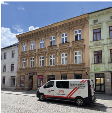
Bytový dům Jihlava
