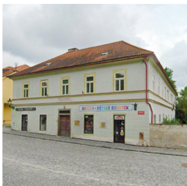
Bytový dům Písek
