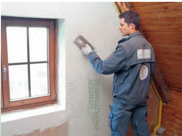
nanášení vnitřní stěrky UdiMULTIGRUND®
