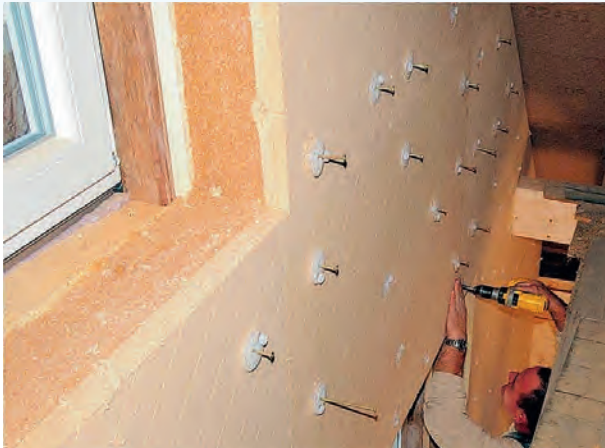
přípevnění desek UdiRECO® pomocí rektifikovatelných hmoždinek
