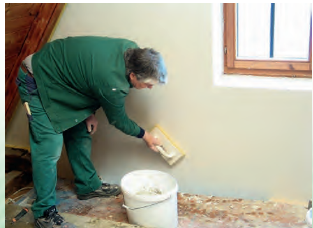
vyhlazení povrchu UdiMULTIGRUND®
