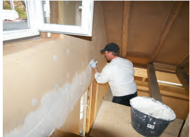
armování, osazení systémových profilů
