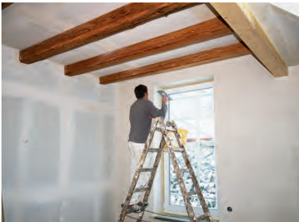
dokončovací práce, vyhlazení vnitřní stěrky UdiMULTIGRUND® před vymalbou
