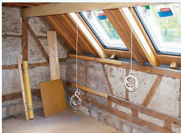
stav před zateplením
