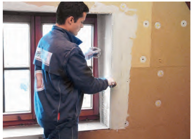
osazení ochranné rohové lišty UdiARMIERUNG®
