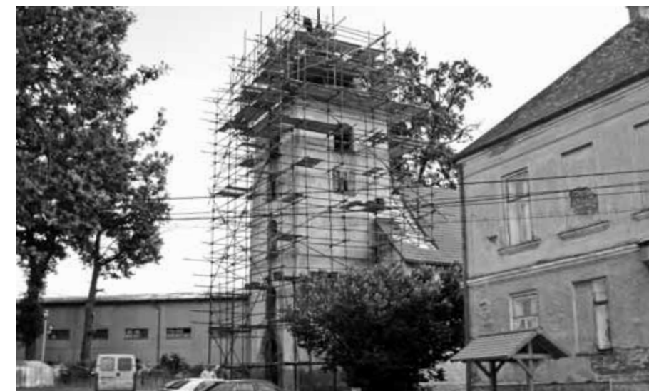
OBNOVA VENKOVNÍHO PLÁŠTĚ NA VĚŽI KOSTELA
