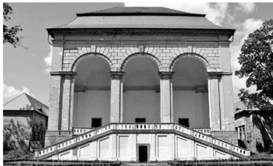
VALDŠTEJNSKÁ LODŽIE V JIČINĚ BYLA VYHODNOCENA NA STRÁNKÁCH ČESKÝ RÁJ BEZ BARIÉR JAKO DOBRĚ PŘÍSTUPNÁ HENDIKEPOVANÝM.
