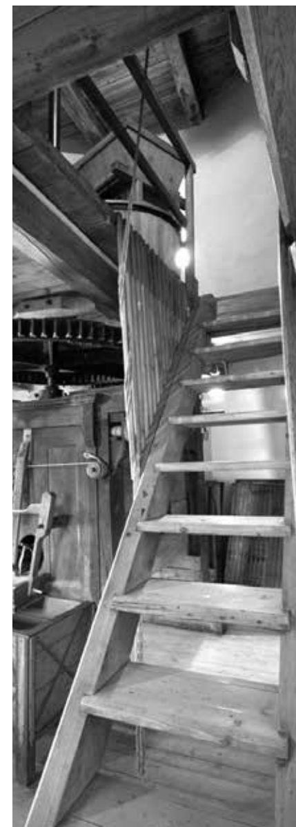
SCHODIŠTĚ DO PRVNÍHO PATRA – NA ZANÁŠKU. DOLE JE MOUČNICE, NAHOŘE MLECÍ SLOŽENÍ.
