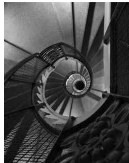
PŮVODNÍ KOVOVÉ ZÁBRADLÍ ZDOBÍ STYLIZOVANÉ PŘÍRODNÍ MOTIVY.
