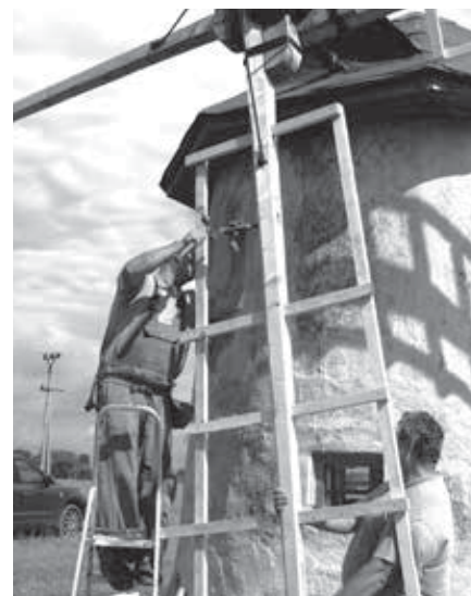
ZÁVĚREČNÝM A SLAVNOSTNÍM KROKEM BYLA MONTÁŽ REPLIKY PŮVODNÍCH VĚTRNÝCH PERUTÍ.
