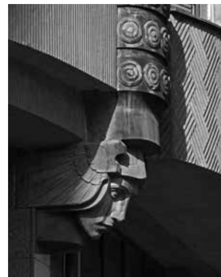
MĚDĚNÉ KONSOLY V PODOBĚ HLAVY MERKURA NESOU BALKON V PRVNÍM PATŘE.
