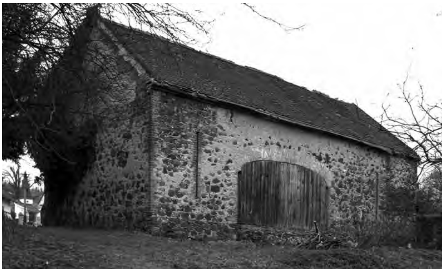
K HISTORII STODOLY SE NEZACHOVALY TĚMĚŘ ŽÁDNÉ INFORMACE. VÝJIMKOU JE LETOPOČET 1886, KTERÝ SE NACHÁZÍ V OMÍTCE NAD BÝVALÝM PRŮJEZDEM.
