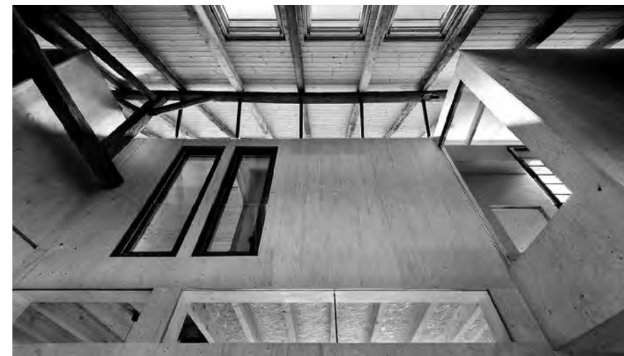
VLOŽENÍM NOVOSTAVBY DO STARÉHO STAVENÍ SE VYŘEŠILY LIMITY, KTERÉ MĚLO VLHKÉ ZDIVO STARÉ STODOLY BEZ ZÁKLADŮ.
