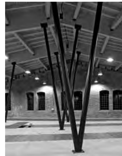
PŘI OBNOVĚ VÝTOPNY SE PODAŘILO SPOJIT PŮVODNÍ A NOVÉ PRVKY STAVBY.
