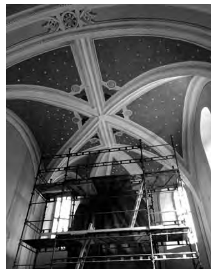
STAVBU SE PODAŘILO STABILIZOVAT A BYLY DOKONČENY OPRAVY INTERIÉRU.
