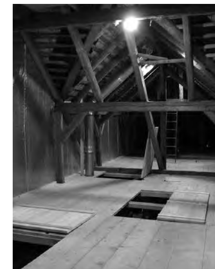
UNIKÁTNÍ SYSTÉM VZDUCHOTECHNIKY VYUŽÍVÁ PŘÍROZENOU CÍRKULACI VZDUCHU.
