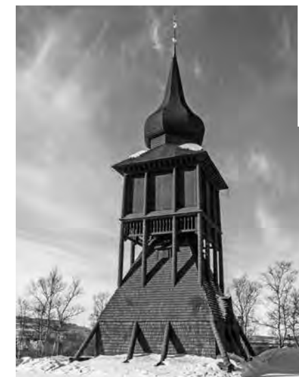
PLÁNUJE SE PŘESUN 21 STAVEB.
