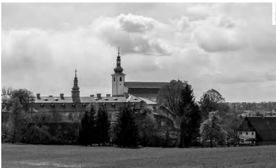
CELKOVÝ POHLED NA AREÁL BÝVALÉHO KLÁŠTERA S KOSTELEM
