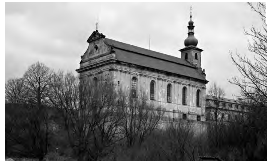
POHLED NA KOSTEL PŘED REVITALIZACÍ
