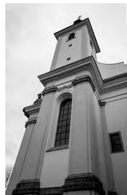
OPRAVA FASÁD ZAHRNOVALA REPASE OKENNÍCH VITRÁŽOVÝCH VÝPLNÍ.
