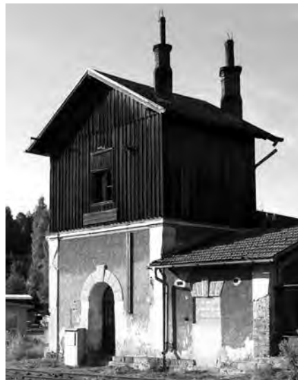
OBSLUŽNÉ DRÁŽNÍ STAVBY PATŘÍ V SOUČASNOSTI K NEJOHROŽENĚJŠÍM.
