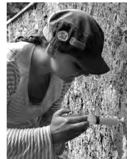
LETNÍ ŠKOLY PŘÍBLÍŽUJÍ ZÁKLADY RESTAUROVÁNÍ, NAPŘÍKLAD INJEKTOVÁNÍ ODDĚLENÉ OMÍTKY.
