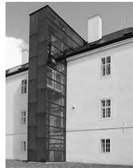
SOUDOBA PŘÍSTAVBA VÝTAHOVÉ ŠACHTY UMOŽŇUJE BEZBARIÉROVÝ PŘÍSTUP DO ZÁMECKÝCH EXPOZIC.
