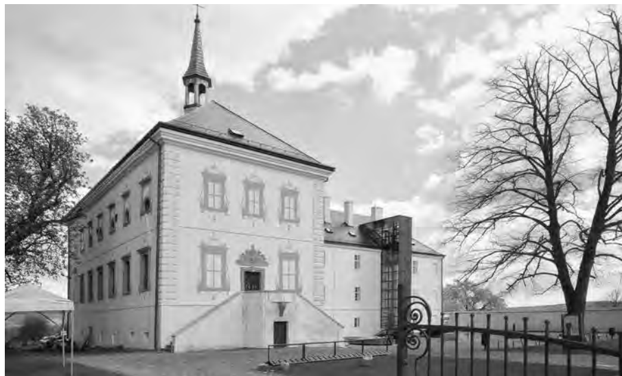
PRVNÍ FÁZE OBNOVY ZÁMKU TRVALA 12 MĚSÍCŮ. LETOS V KVĚTNU BYLA DOKONČENA DRUHÁ ETAPA.
