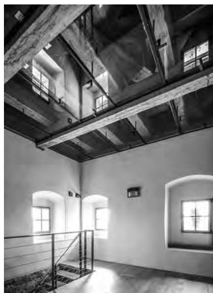
PROSKLENÍ NÁVŠTĚVNÍKŮM ATRAKTIVNĚ ZPŘÍSTUPŇUJE OPRAVENÝ KROV.
