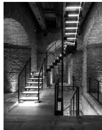
RESTAUROVÁNO BYLO PŮVODNÍ KAMENNÉ VŘETENOVÉ I OCELOVÉ SCHODIŠTĚ.
