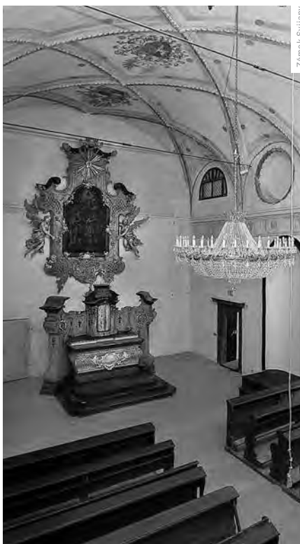
KOMPLETNÍ RESTAURÁTORSKOU OBNOVOU PROŠEL OLTÁŘ V KAPLI SV. JANA A PAVLA.
