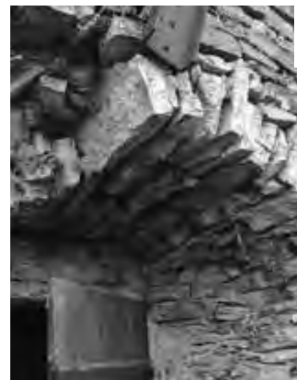
DETAIL POŠKOZENÉ KLENBY NAD VSTUPNÍ ČÁSTÍ
