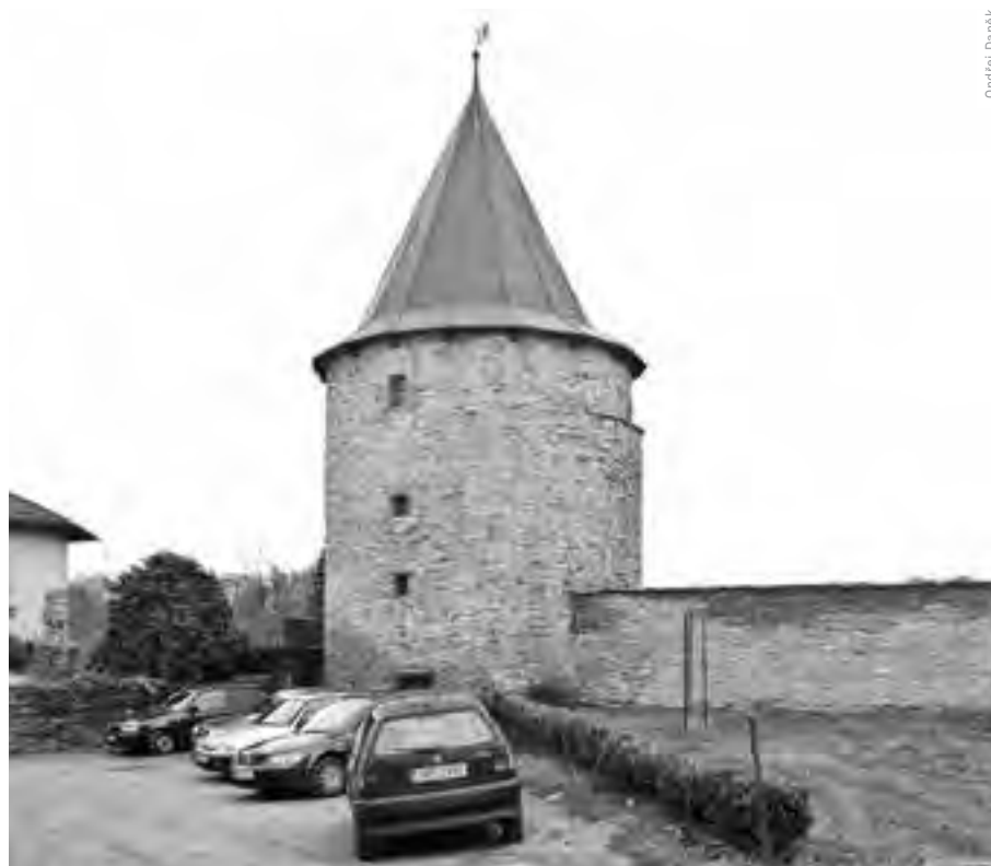
CELKOVÝ POHLED PO PROVEDENÉ PRVNÍ ETAPĚ OBNOVY VNĚJŠÍHO PLÁŠTĚ
