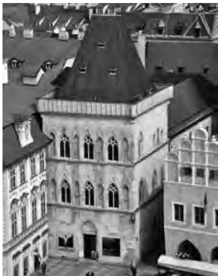
JEDNA Z PRVNÍCH ZAKÁZEK – OBNOVA VNĚJŠÍHO PLÁŠTĚ DOMU U KAMENNÉHO ZVONU V PRAZE
