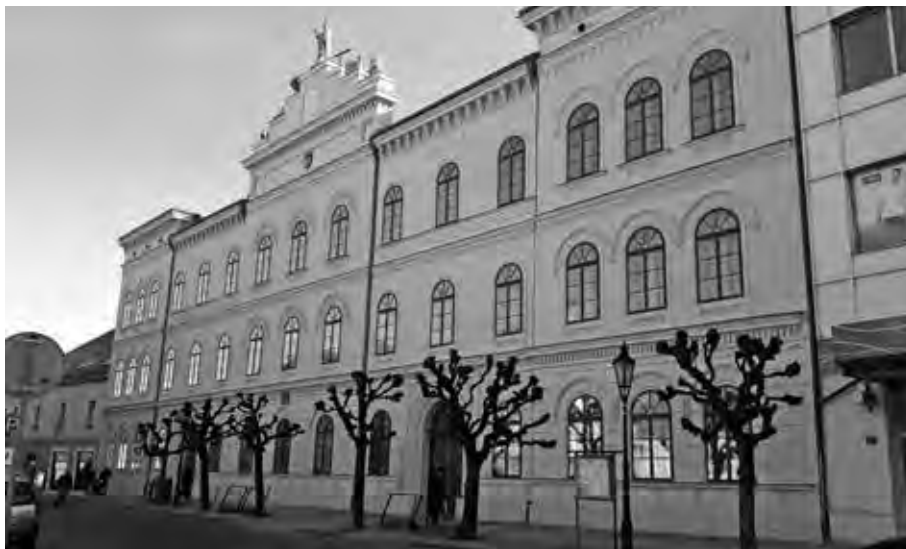
ŠKOLNÍ BUDOVA VZNIKLA VE DRUHÉ POLOVINĚ 19. STOLETÍ NA MÍSTĚ TŘÍ STARŠÍCH DOMŮ.
