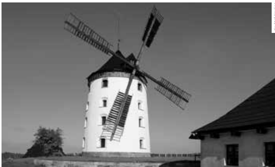
LOPATKY, PERUTĚ A HLAVNÍ HŘÍDEL JSOU VYROBENY KLASICKÝM TESAŘSKÝM POSTUPEM.
