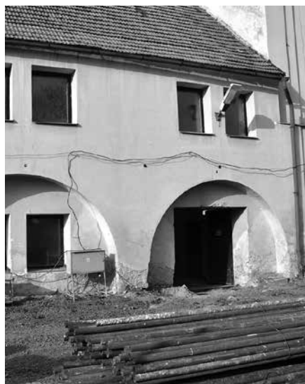
PŮVODNÍ STAV BÝVALÉHO KLÁŠTERNÍHO PIVOVARU
