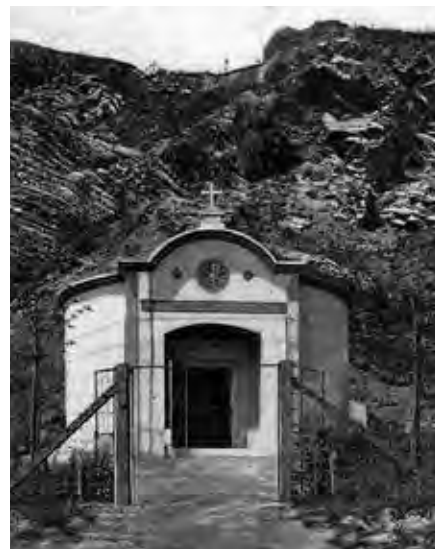
VZHLED KAPLE KRÁTCE PO JEJÍM DOKONČENÍ NA POČÁTKU 20. STOLETÍ.
