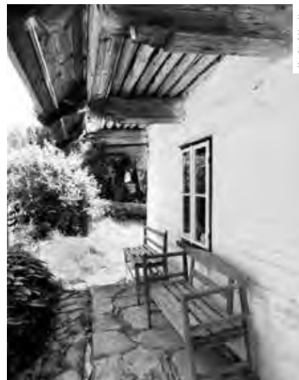
CENNÁ JSOU ZHLAVÍ STROPNÍCH TRÁMŮ.
