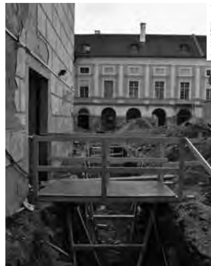
PROBÍHAJÍCÍ POKLÁDKA VODOVODU A SUCHOVODU NA NÁDVOŘÍ HORNÍHO ZÁMKU
