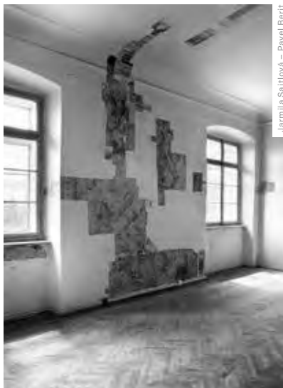
ODKRYVÁNÍ STARŠÍCH OMÍTKOVÝCH VRSTEV V DOLNÍM ZÁMKU
