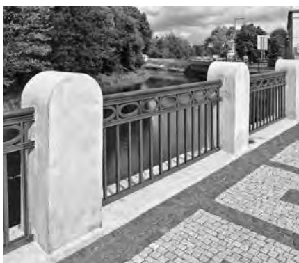
DETAIL KOVANÉHO ZÁBRADLÍ
