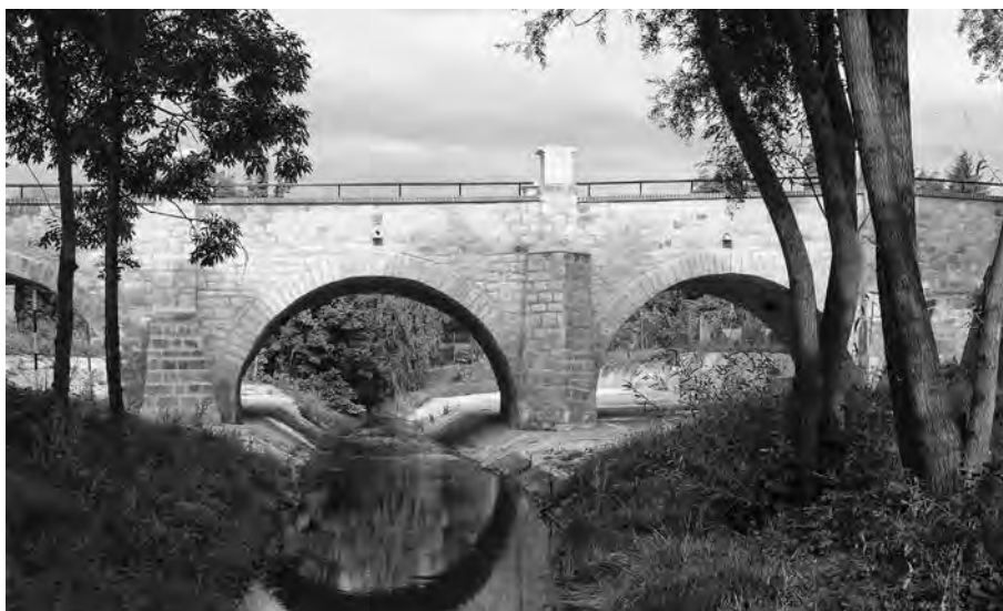
KONSTRUKCI MOSTU V OBCI SAZENA TVOŘÍ VALENÉ KLENBY Z PÍSKOVCOVÉHO ZDIVA.
