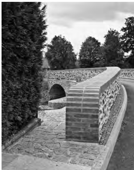
PŘI OBNOVĚ BYLA POUŽITA VÁPENNÁ SPÁROVACÍ MALTA.
