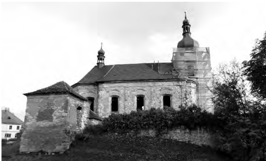
ZMIŇOVANÝ KOSTEL V SIŘEMI SE PŘED NEDÁVNEM DOČKAL NOVÉ BŘIDLICOVÉ STŘECHY A OBNOVY VSTUPNÍ VĚŽE.
