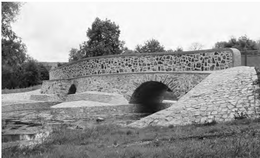
JEDNÁ SE O POMĚRNĚ DLOUHOU, NEPRAVIDELNĚ ZAKŘIVENOU KONSTRUKCI.
