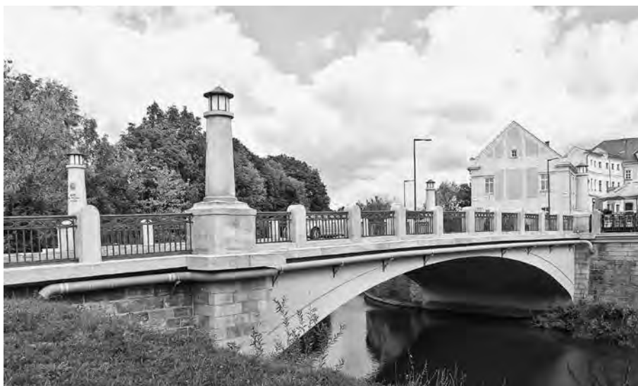
JAROMĚŘSKÝ MOST MÁ SEGMENTOVOU ŽELEZOBETONOVOU KLENBU.
