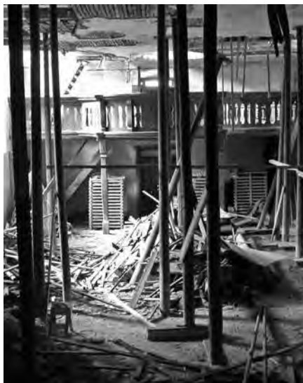
POHLED DO ZNIČENÉHO INTERIÉRU CHRÁMU V NEČEMICÍCH
