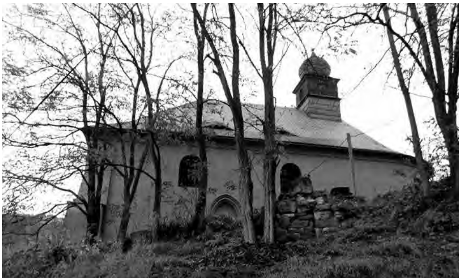
KOSTEL V NEČEMICÍCH PO KOMPLETNÍ OPRAVĚ FASÁDY, STŘECHY A VĚŽIČKY
