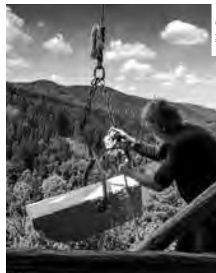
OSAZOVÁNÍ KAMENNÝCH KRACORCŮ NA OCHOZU VĚŽE
