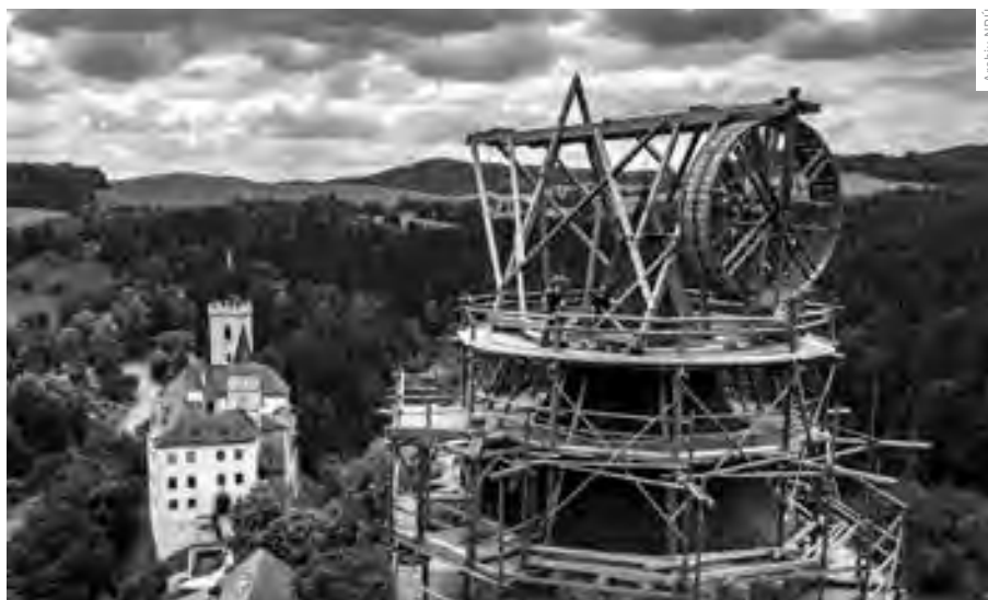
ROTAČNÍ JEŘÁB INSPIROVANÝ STROJÍ LEONARDA DA VINCE POMOHL VYTÁHNOUT DO VÝŠKY 30 METRŮ ZHRUBA 25 TUN MATERIÁLU.
