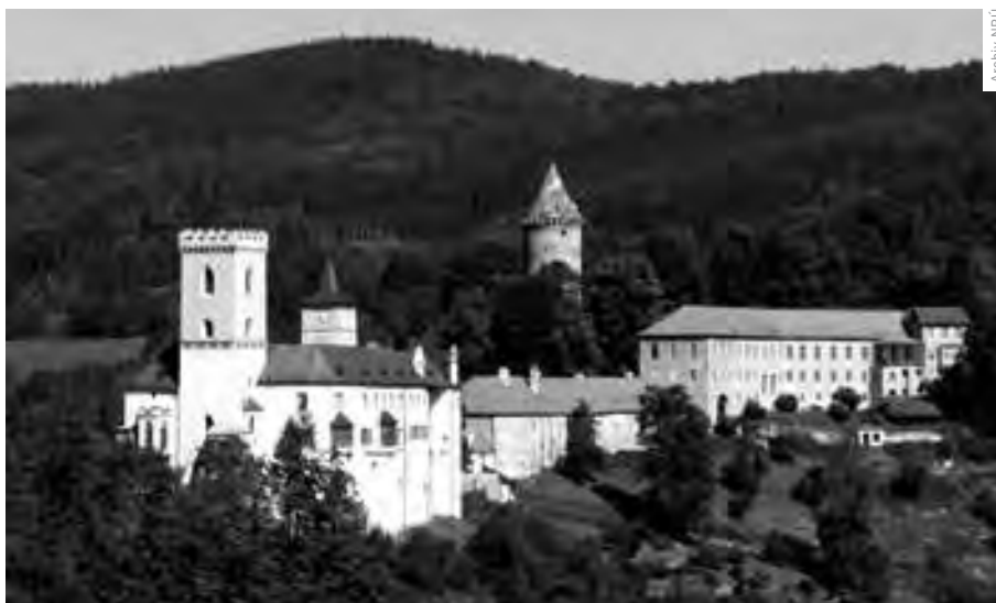
POHLED NA AREÁL ROŽMBERSKÉHO DVOJHRADÍ S VĚŽÍ JAKOBÍNkou PŘED REKONSTRUKCÍ V ROCE 2012
