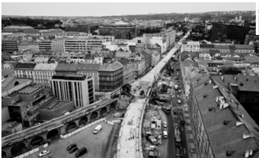
POHLED Z PTAČÍ PERSPEKTIVY NA TĚLESO VIADUKTU BĚHEM OPRAV
