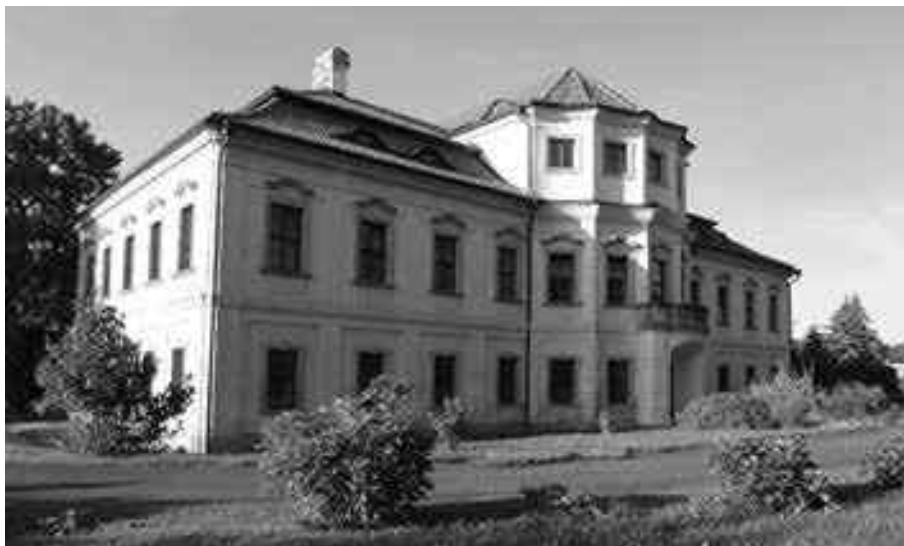
BAROKNÍ ZÁMEK PŘICHOVICE VZNIKL PŘESTAVBOU STŘEDOVĚKÉ TVRZE V LETECH 1718–1719 V DUCHU MAISON DE PLAISANCE.
