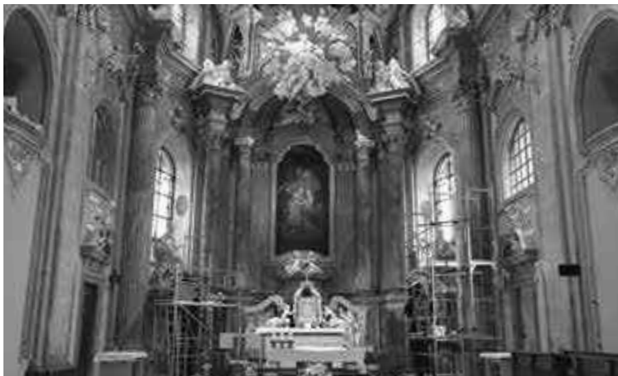
KROMĚ BAZILIKY NAVŠTÍVENÍ PANNY MARIE NA SVATÉM KOPEČKU U OLOMOUCE JSOU OBNOVOVÁNY TAKÉ SÁLKY V PRAVÉM KŘÍDLĚ POUTNÍHO AREÁLU. OSTATNÍ PROSTORY MUSÍ NA OPRAVU POČKAT DO BUDOUCNA.
