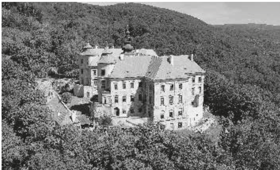
ZÁMEK NA ROZHRANÍ DVOU SVĚTŮ – PŘÍHODNÉ OZNAČENÍ PRO JEZEŘÍ, NĚKDEJŠÍ SÍDLO RODU LOBKOWICZŮ, KTERÍ MU VTISKLI BAROKNÍ PODOBU. VEŘEJNOSTI BYL ZPŘÍSTUPNĚN I PŘES NEUTĚŠENÝ STAV V ČERVNU 1996.
