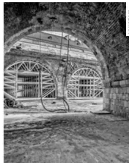
DETAIL PRŮBĚHU REKONSTRUKCE KLENEB
