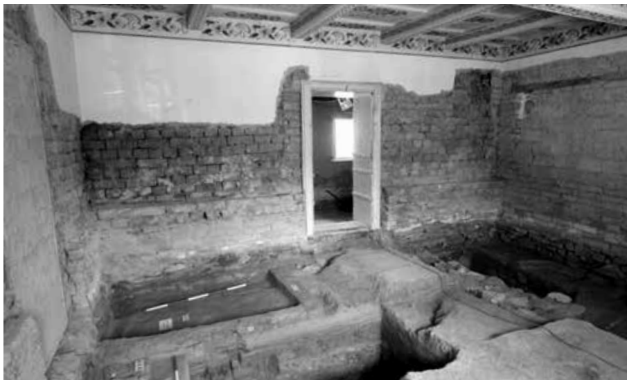
VÝZKUM SVĚTNICE USEDLOSTI ČP. 43 V KUČEROVĚ ODHALIL NĚKOLIK STAVEBNÍCH FÁZÍ DOMU, JEHOŽ MINULOST SAHÁ AŽ DO 14. STOLETÍ.
