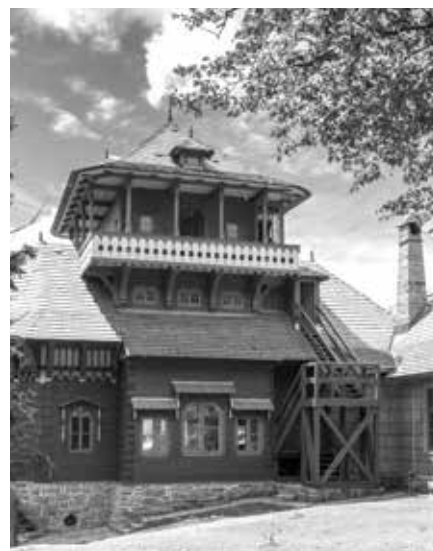
VEŠKERÉ TESAŘSKÉ A TRUHLÁŘSKÉ PRÁCE BYLY PROVEDENY RUČNĚ.
