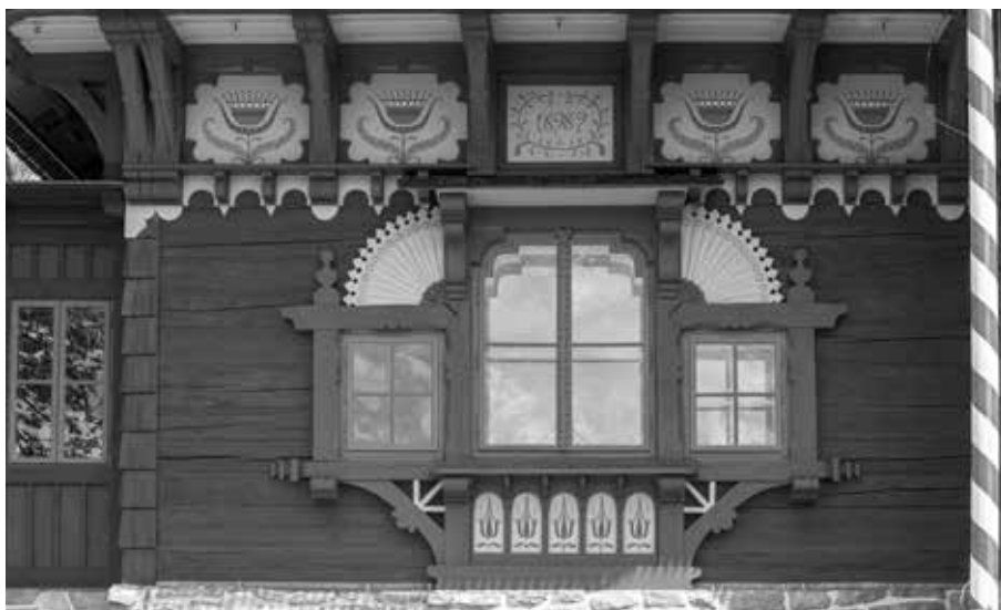
OKNO, KTERÉ SE PO PŘEDCHOZÍ REKONSTRUKCI OCITLO V DEPOZITÁŘI, BYLO ZRESTAUROVÁNO, VYPLNĚNO HISTORIZUJÍCÍM SKLEM A VRÁCENO NA PŮVODNÍ MÍSTO.
