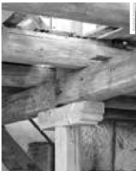
POHLED NA DŘEVĚNOU KONSTRUKCI V INTERIÉRU V ROCE 2019
