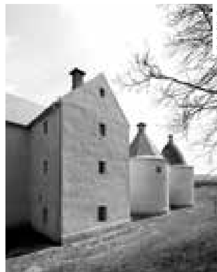
NA VNĚJŠÍ FASÁDU BYL APLIKOVÁN VÁPENNÝ NÁTÉR V OKROVÉM ODSÍNĚ.
