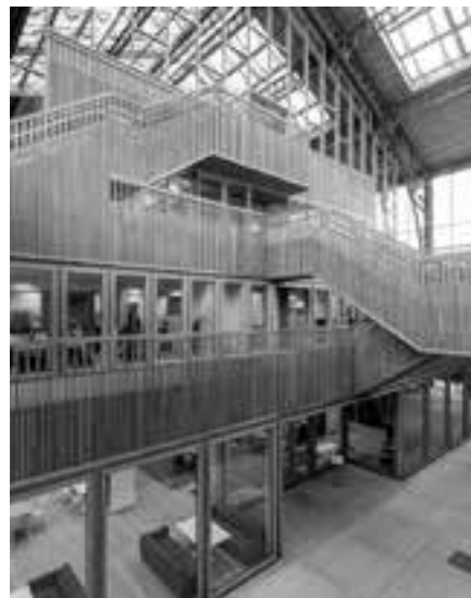
BÝVALÉ NÁKLADNÍ NÁDRAŽÍ GARE MARITIME V BRUSELU
