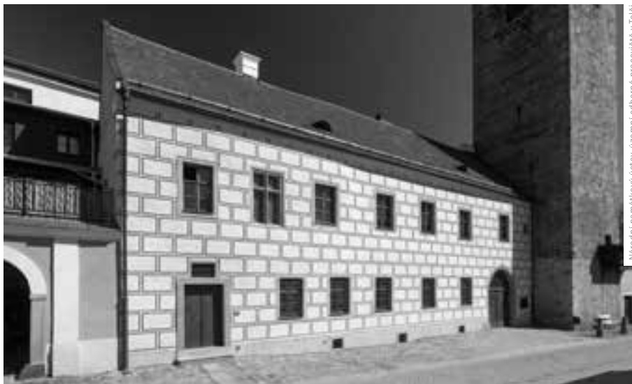
KVALITNÍ OBNOVA RENESANČNÍ FASÁDY S MALOVANOU RUSTIKOU, POLYCHROMOVANÝMI KAMENNÝMI PRVKY, ŠPALETOVÝMI OKNY, VSTUPNÍMI DVEŘMI A VRATY DLE DOBOVÝCH PŘEDLOH VRÁTILA NEXOVÉ DOMU DŮSTOJNÝ VZHLED.
