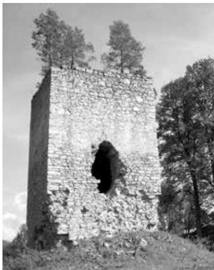
STAV KAMENNÉ VĚŽE PŘED REKONSTRUKCÍ SE VZROSTLÝMI NÁLETOVÝMI DŘEVINAMI
