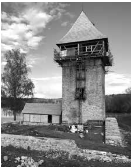
VĚŽ S DOKONČENÝM ZASTŘEŠENÍM DLÁTKOVOU STŘECHOU KRYTOU VLAŠSKÝM ŠINDELEM
