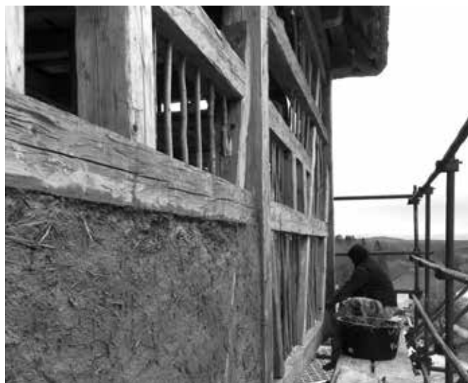
KONSTRUKCE NOSNÉHO HRÁZDĚNÍ, POSTUPNÉ PROVÁDĚNÍ VYMAZÁVKY STĚN – EXTERIÉR
