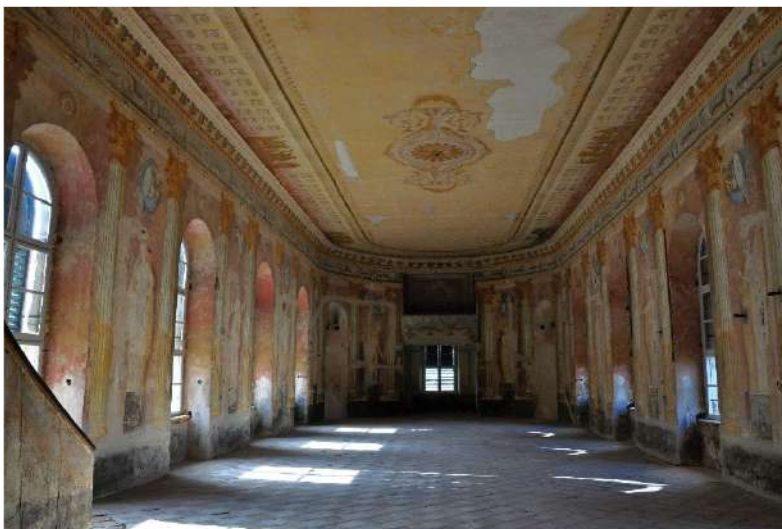
Banketní sál zámku Uherčice – původní stav před zahájením rekonstrukce.
