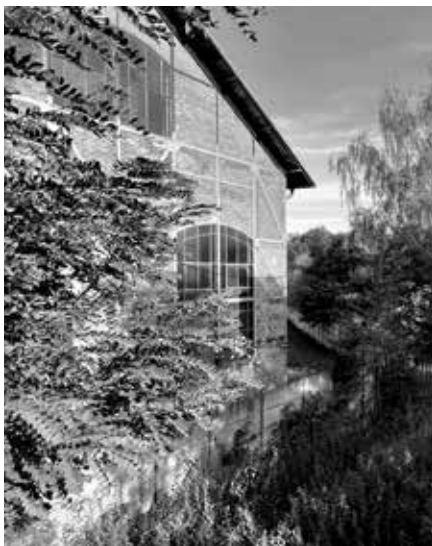
STROJOVNA A KOMPRESOROVNA DOLU BARBORA, PAMÁTKOVĚ CHRÁNĚNÁ A RENOVOVANÁ V ROCE 2015. V SOUČASNOSTI JE PRO VEŘEJNOST NEPŘÍSTUPNÁ.
