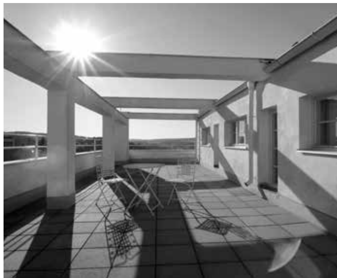
NEJVYŠŠÍ TERASA S MASIVNÍ PERGOLOU NA ČTYŘECH PILÍŘÍCH NABÍZÍ KRÁSNÉ VÝHLEDY NA PRAHU.
