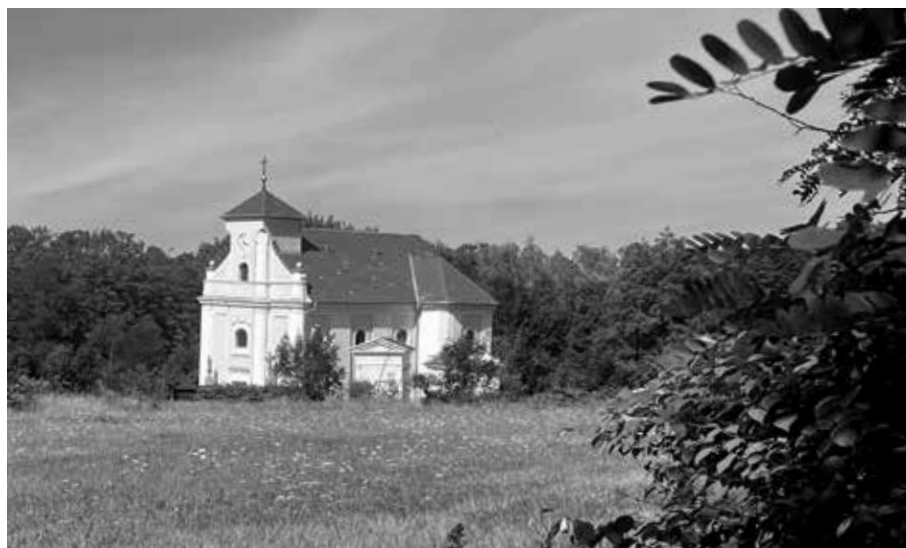
KOSTEL SV. PETRA Z ALKANTARÝ. KOSTEL MĚL BÝT ZBOŘEN, NESTALO SE TAK JEN DÍKY ÚSILÍ FARÁŘE ERNESTA DOSTÁLA V ÚVODU 90. LET.
