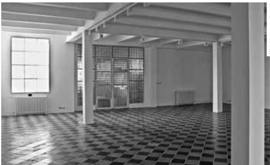
OBNOVENÁ BETONOVÁ DLAŽBA VE DRUHÉM NADZEMNÍM PODLAŽÍ
