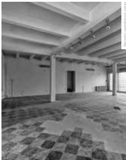
ODHALENÁ PŮVODNÍ BETONOVÁ DLAŽBA VE DRUHÉM NADZEMNÍM PODLAŽÍ
