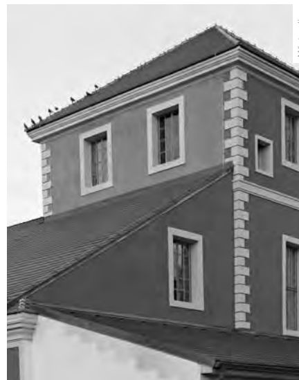
DETAIL OBNOVENÉ FASÁDY S OKNY SE SUBTILNÍM ČLENĚNÍM
