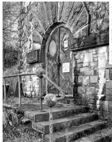
DETAIL ROZMĚRNÉ KOULE ZAKONČUJÍCÍ MADLO ZÁBRADLÍ
