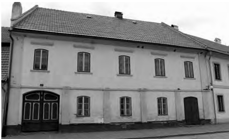
PAMÁTKOVĚ CHRÁNĚNÝ POZDNĚ KLASICISTNÍ DŮM JE SOUČÁSTÍ URBANISTICKÉ ZÁSTAVBY JÁDRA MĚSTYSE.
