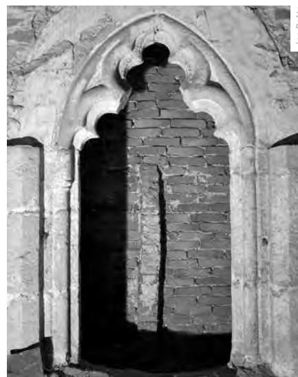
RANĚ GOTICKÉ KRUŽBOVÉ OKNO NA PŮDĚ KOSTELA SV. PROKOPIA VE STRAKONICÍCH
