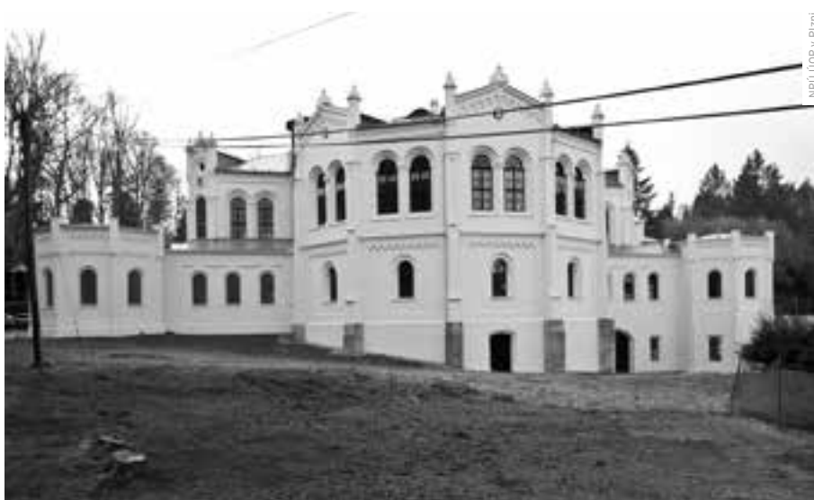
CELKOVÝ POHLED NA JÍZDÁRNU V SOUČASNOSTI
