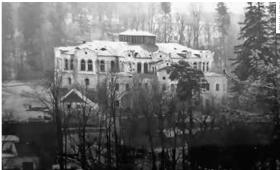
NEUTĚŠENÝ TECHNICKÝ STAV PŘED OBNOVOU
