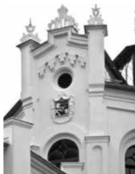
DETAIL OPRAVENÉ FASÁDY
