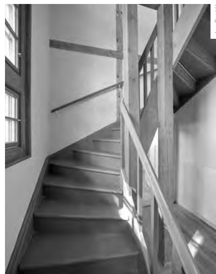
OBNOVENÉ JURKOVIČOVO SCHODIŠTĚ
